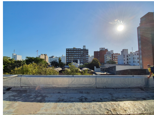
(d) Vista hacia el oeste
