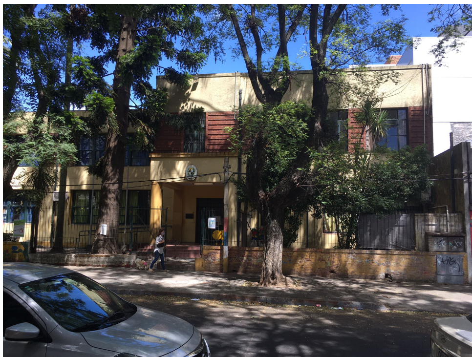
(a) Fachada este (desde la calle Simón Bolívar)
