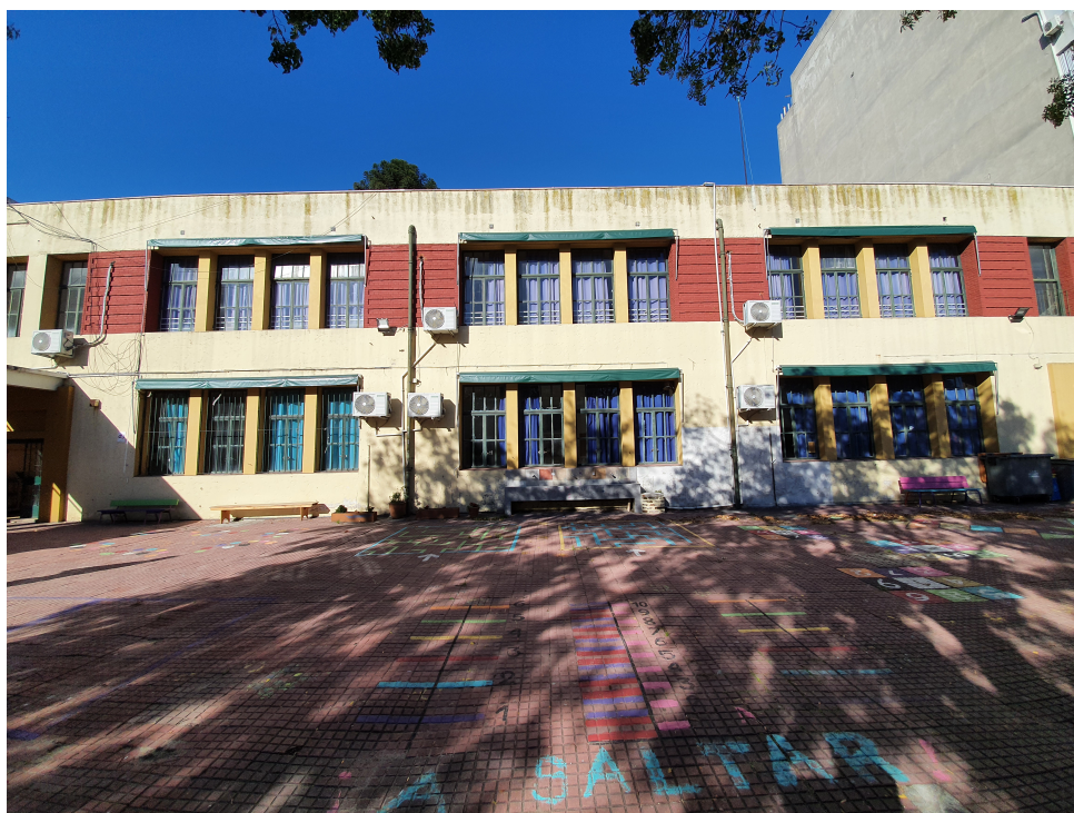
(b) Fachada oeste (desde el patio)
