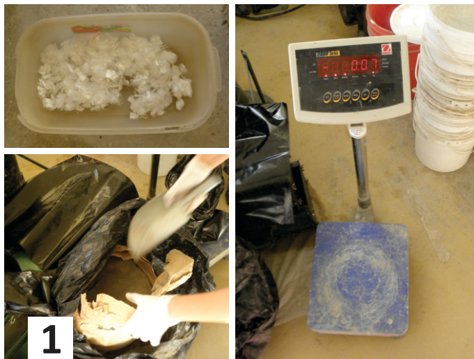
Fig. 45. Balanza y contenedores con agua; fibras de polipropileno; cemento. Preparación de los insumos: pesado de los componentes sólidos; cemento, arena y fibras.
