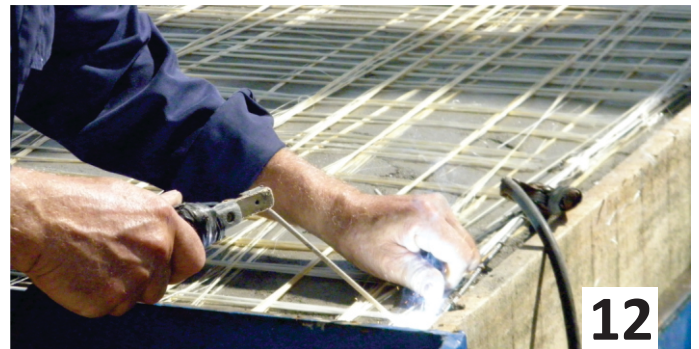
Fig. 66. Colocación de la segunda malla metálica, soldado entre las mallas. Colocación de la segunda malla metálica y unión de la misma con la primera capa metálica a través de soldaduras en sus 4 extremos.
