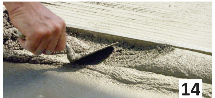
Fig. 68. Alisado de la superficie. No se realizan terminaciones sobre el la superficie del panel, simplemente se alisa. En caso de agrietarse se busca humedecer la superficie para disminuir las fisuras.
