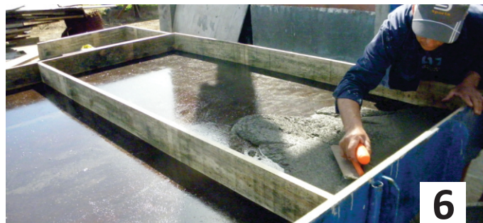
Fig.60. Molde de los 3 paneles. Colocación de la primer capa de MHAD. Finalizada la mezcla se pasa a colocar la primer capa de MHAD, 10mm aprox. en el molde.
