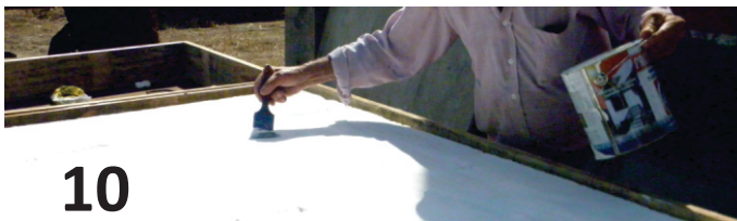
Fig. 64. Aplicación de la pintura. Se aplica sobre el espuma plast una capa fina de pintura para exterior la cuál genera una mayor adhesión con el mismo y lo protege de la humedad de la mezcla.
