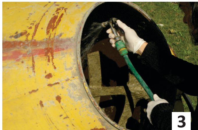
Fig. 47. Humificación de la hormigonera (3 bolsas). Humificación de la hormigonera para una mejor mezcla y para evitar que el agua del MHAD sea absorbida por el material de la misma.
