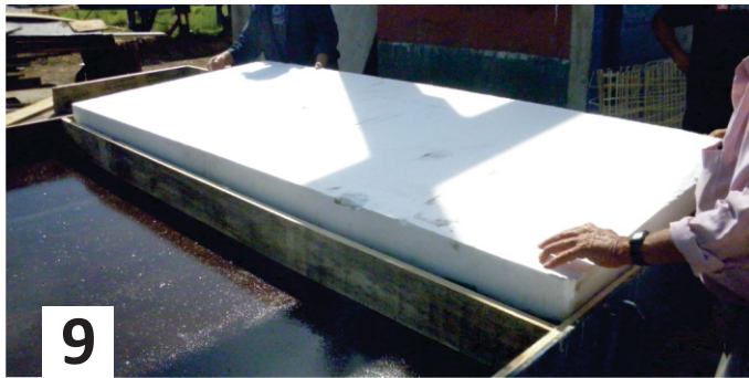
Fig. 61. Colocación del espuma plast. Colocación del espuma plast (100mm de espesor aprox. y dimensión 30mm aprox. menor al molde para generar un contorno de MHAD en el relleno final) sobre el MHAD.
