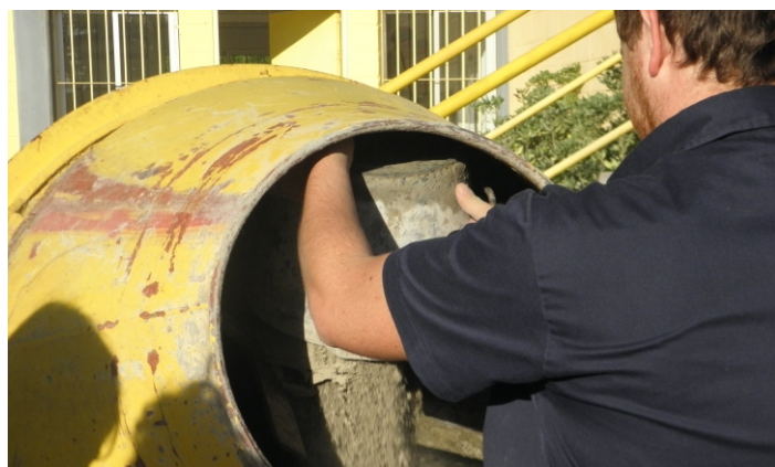
Fig. 29. Colocación de los componentes en la hormigonera. | Fuente: Elaboración propia.
