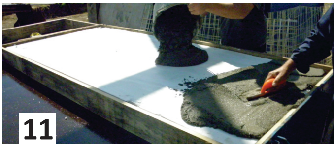
Fig. 65. Colocación de la tercer capa de MHAD. Tercera capa de MHAD (10mm de espesor aprox.) sobre el espuma plast.
