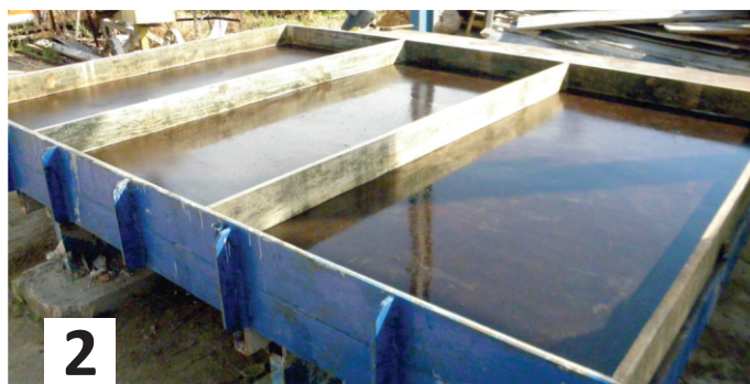
Fig.59. Molde de los 3 paneles.
