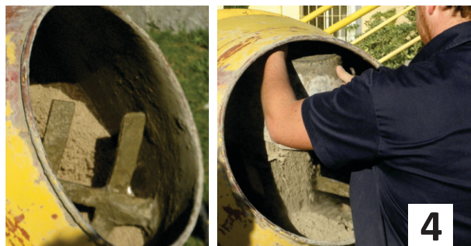
Fig. 48. Agregado de la arena y agregado del cemento. Colocación de los insumos sólidos dentro de la mezcladora; arena, fibras y cemento. Se gira el cuerpo de la mezcladora unas pocas veces para mezclarlos en seco (aporta a la homogenización final y a la dispersión de la fibras).
