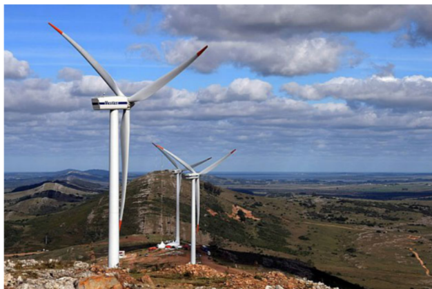
Figura 3. Parque eólico de UTE ubicado en Artigas, Uruguay [6].
