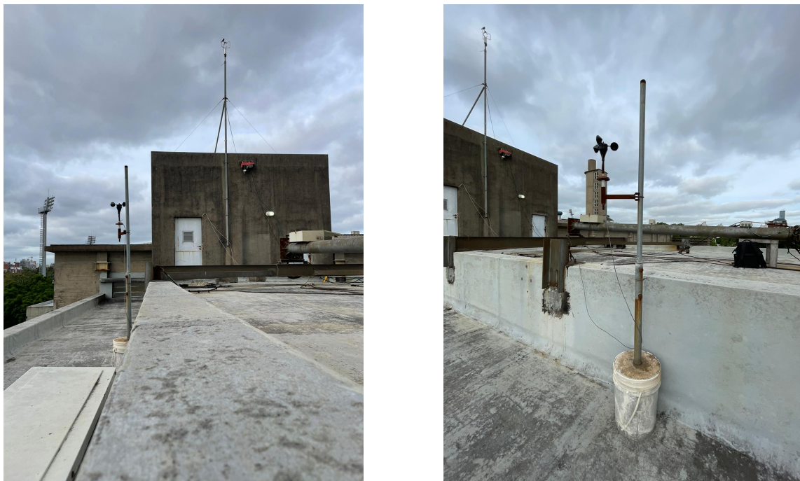
Figura 3.3.1: Vistas de la azotea donde se pueden diferenciar ambos anemómetros: de cazoletas a menor altura y ultrasónico a mayor.
