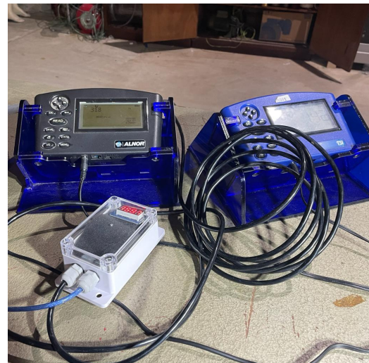
(d) Sensores de presión diferencial, y sensor de temperatura.
