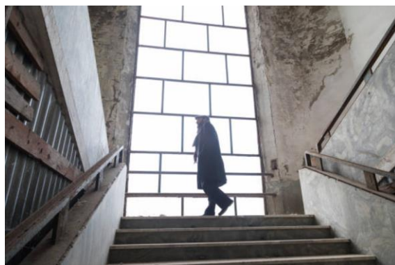
240. Casa del Fascio e dell'ospitalità 186
