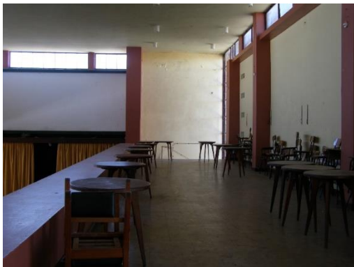
186. Vista del entrepiso, 2010
