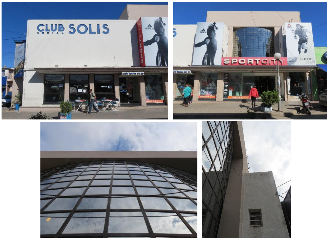
113-116. Detalles fachada Artigas, 2020
