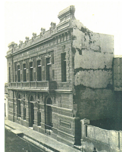
2. Fachada posterior a la reforma de 1907
