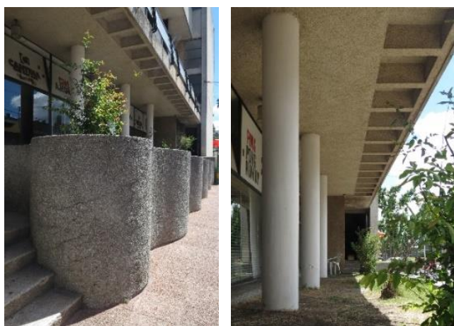
224-226. Detalles de planta baja, fachada Batlle y Ordóñez, 2023.
