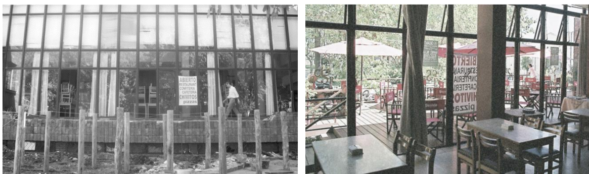
203-206. Proceso de construcción de la terraza de expansión del bar 141
