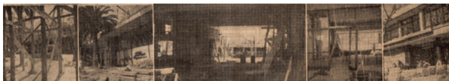
13. Proceso de construcción de la sede, 1953
