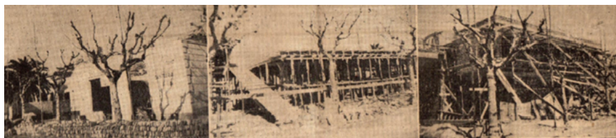
12. Obras de demolición, iniciadas en mayo 1953
