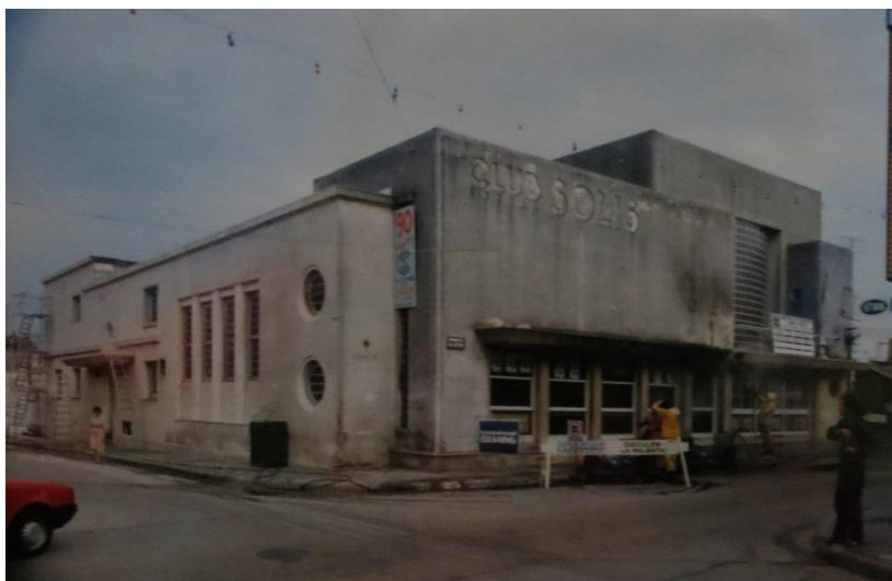
127. Estado de conservación del Club, año 1987 63
