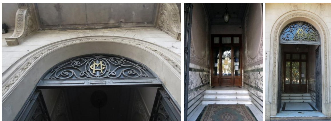
88-90. Detalles del acceso por la calle Treinta y Tres, 2021
