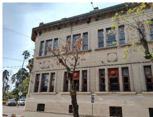
73. Fachada lateral del volumen principal, 2023
