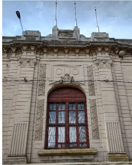
74. Detalle de la fachada de la construcción adosada, 2023
