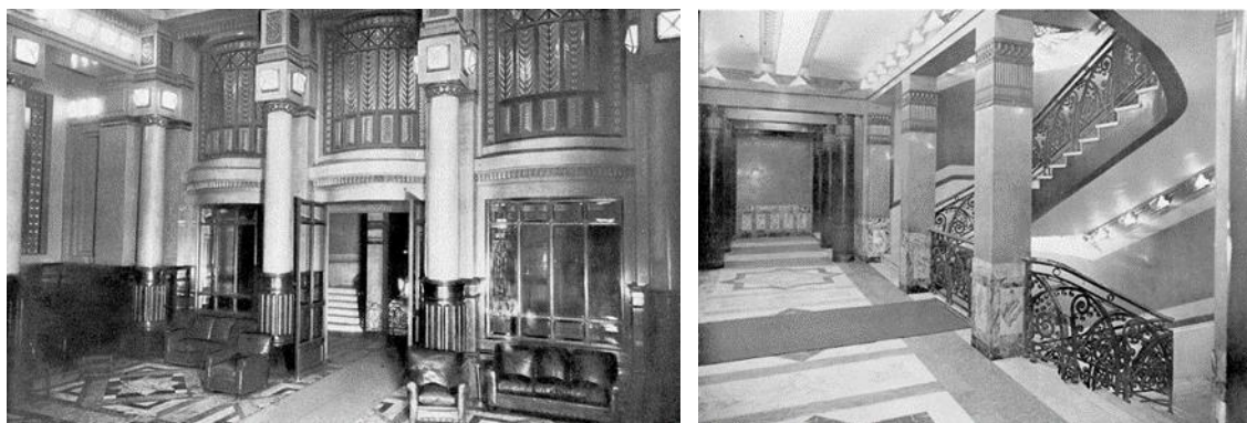
47-48. Vista del hall principal y detalle del corredor y la escalera principal 68
