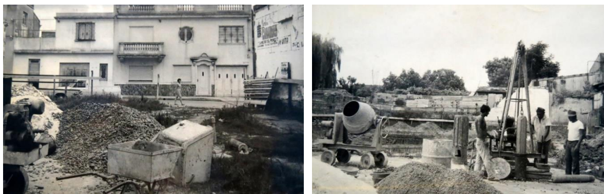
125-126. Imágenes del proceso de construcción
