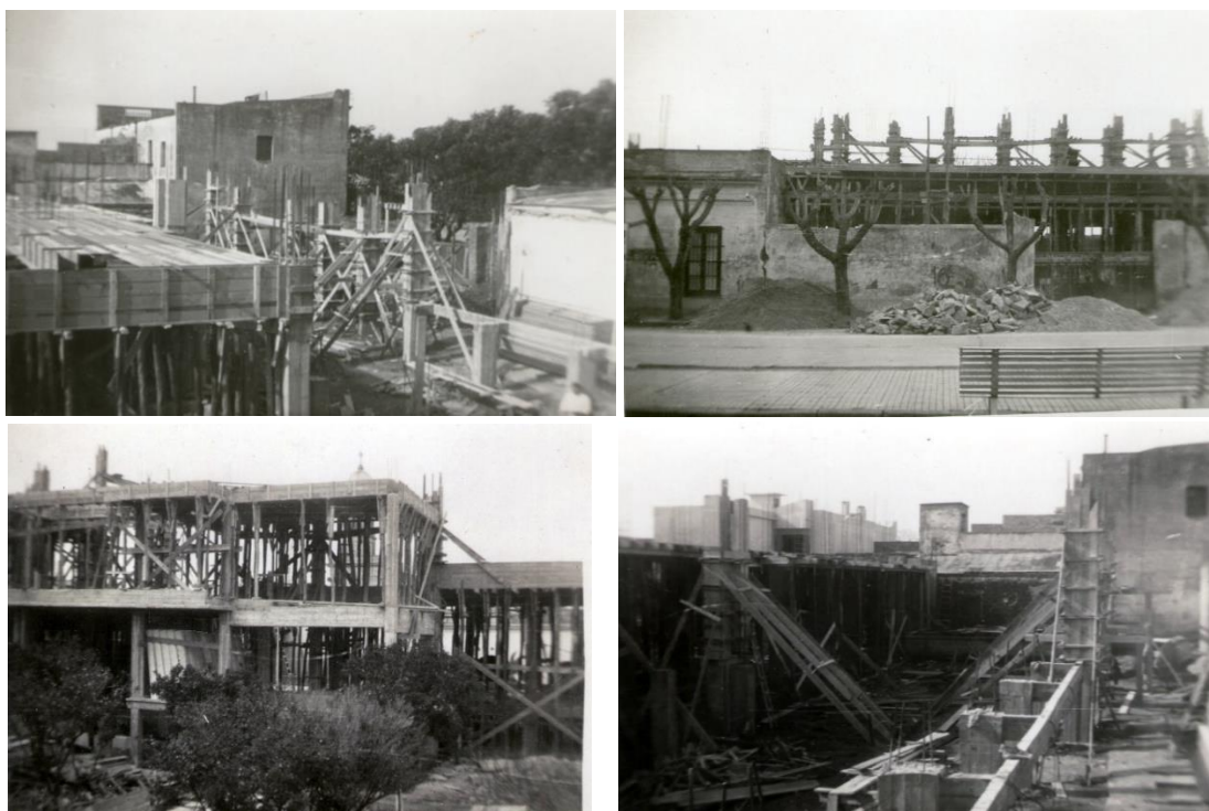
194-197. Imágenes del proceso de construcción, año 1952 129
