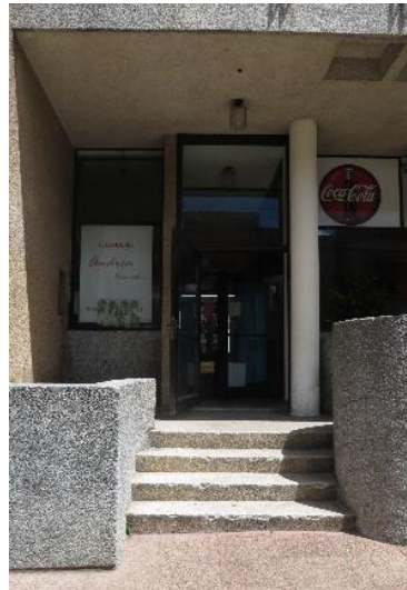
230. Acceso secundario por Batlle y Ordóñez, 2020
