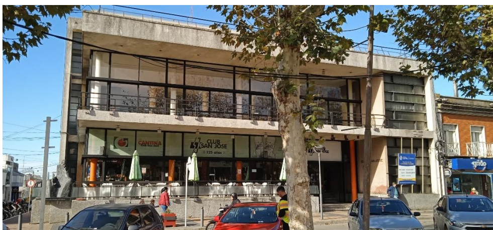
219. La transparencia determinada por los paños vidriados permite percibir desde el exterior los pilares que conforman la estructura
