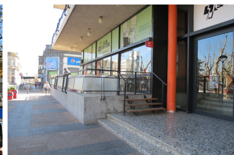
3. Detalle terraza de planta baja, 2022
