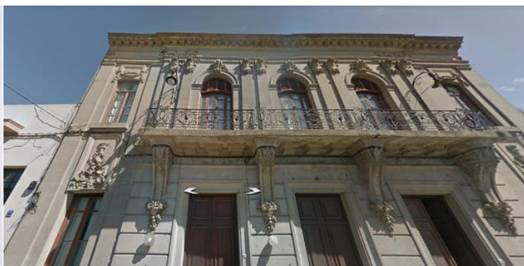
79. Detalle de fachada 87
