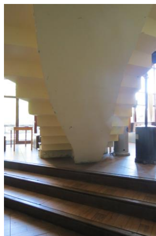
172. Detalle apoyo escalera, 2022
