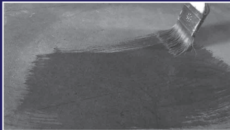
Figura 101 - Aplicación de desmoldante sobre superficie de apoyo.
