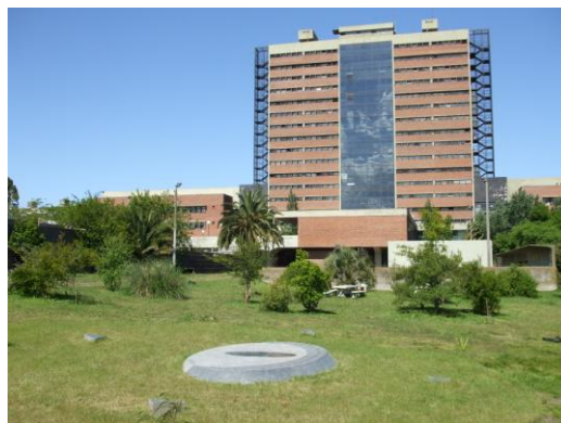
Ilustración 38. Espacio exterior de la Facultad de Ciencias. Departamento de Montevideo.
