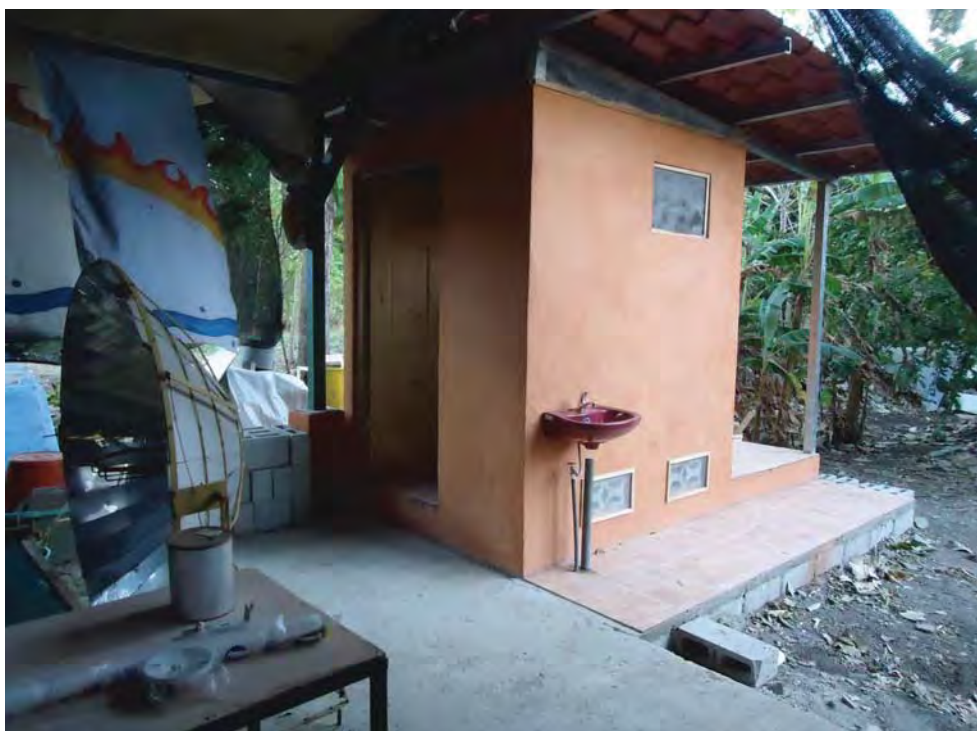
Ilustración 2: Proyecto TC-71. Fotografía de Ronald Arrieta.
