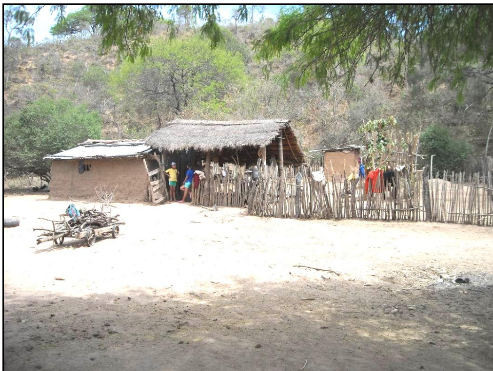
Figura 6. Vivienda de Itaimbeguasú (setiembre de 2009).
