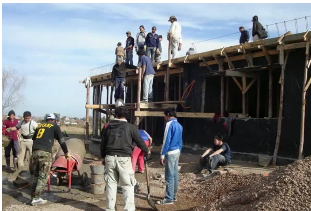
Figura 1: Construcción de la policlínica.
