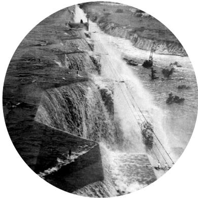
Vista del dique de la margen izquierda de la represa Rincón del Bonete, durante la crecida de abril de 1959. Se puede observar cómo el agua desborda el dique, pasando por encima de los pilares coronados a la cota +84,30 m; el agua llegó a la cota +85,00 m, 0,7 metros más que el nivel en la fotografía.
