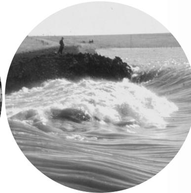
Fotografía del agua pasando por la voladura o brecha, durante la inundación de 1959 en Rincón del Bonete.
