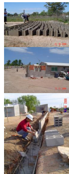
Fig. 35 – Fotos en el proceso de obra. Fotos de la autora, año 2006.
