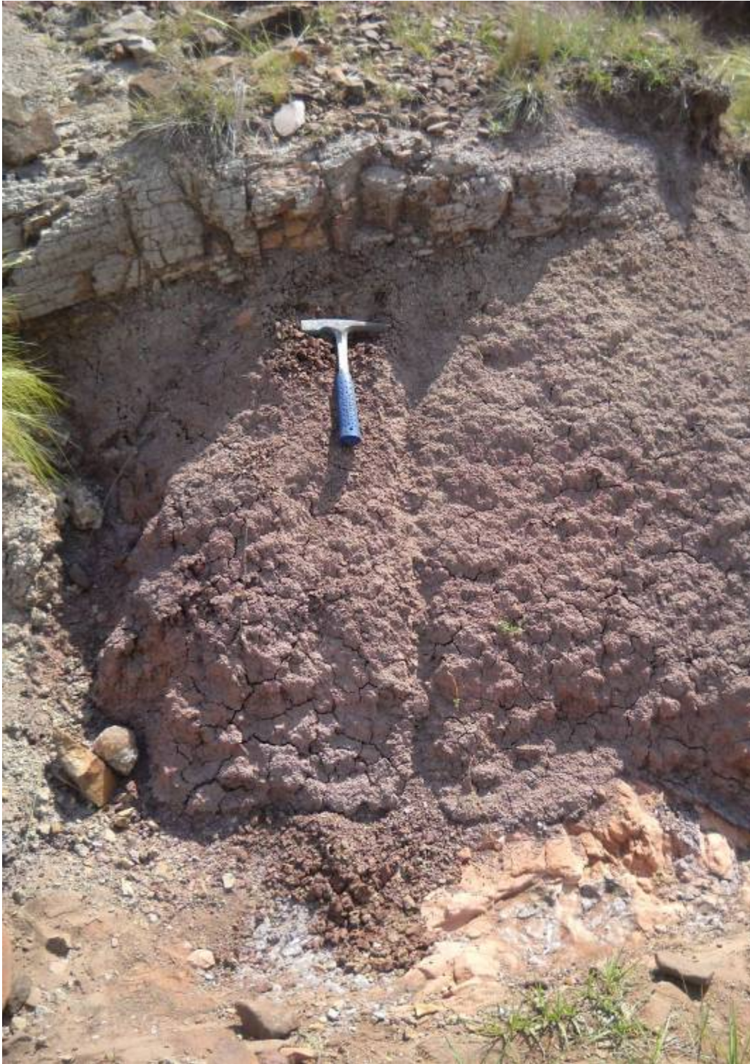
Figura A18. Desmonte en P66 con contacto arenisca-basalto: arenisca en la base, basalto alterado en el medio (coloración violácea) y basalto lajoso en el tope.
