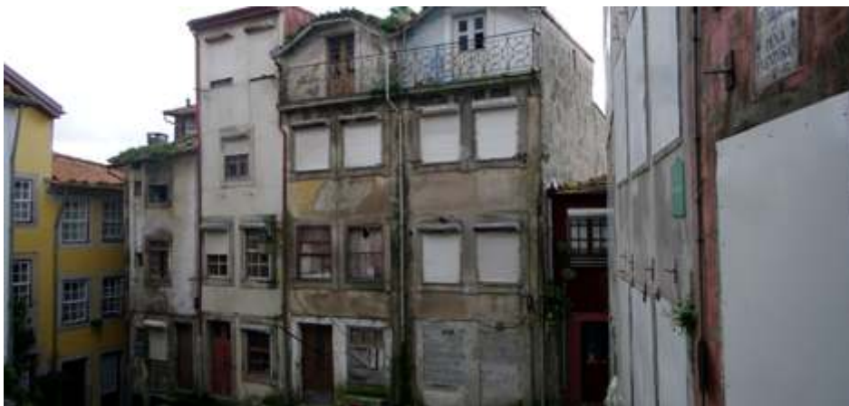
Centro Histórico do Porto Centro Histórico de Porto abandonado y degradado
