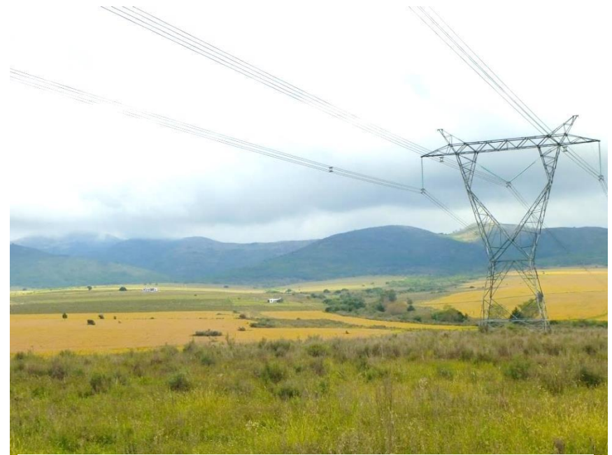
Las líneas de alta tensión demuestran la vulnerabilidad paisajística de la Sierra. P. Di Bello, 2012 5
