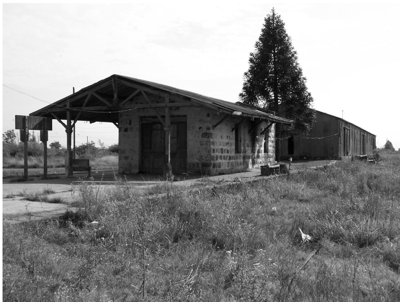
Antigua Estación de Ferrocarriles Cuareim, Bella Unión (en desuso).
