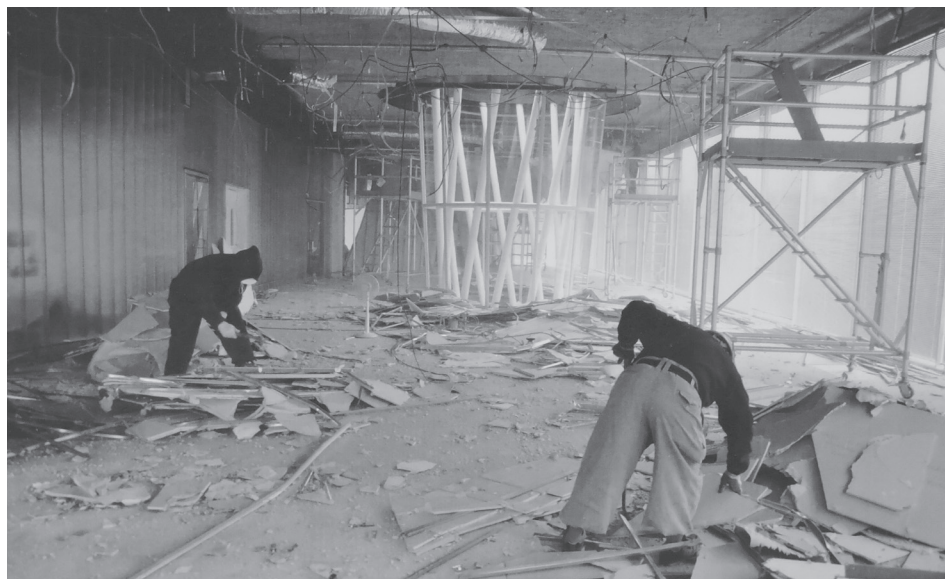
Figura 79. Fotografía interior luego del terremoto de 2011, expuesta en la Mediateca de Sendai. Fotografía: Ignacio Valls, 2014.
