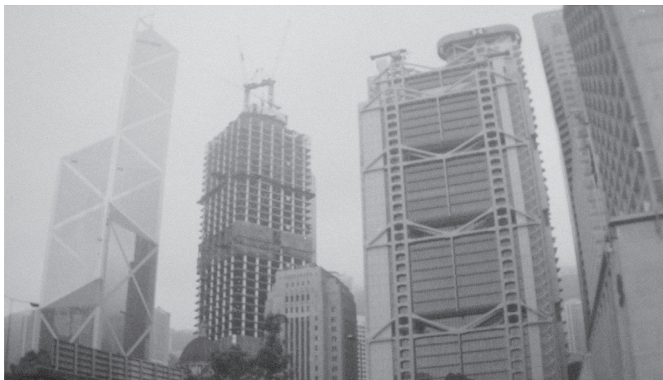
Figura 68. Banco de China de leoh Ming Pei y Hong Kong and Shanghai Bank de Norman Foster, Hong Kong. Fotografía del autor, 1998.
