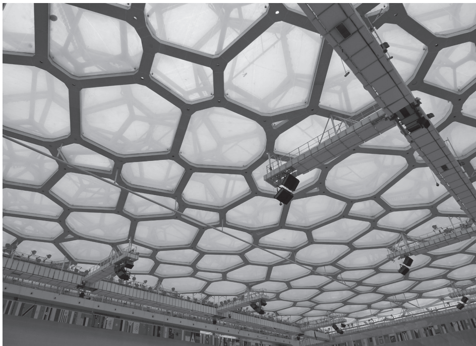
Figura 54. Vista interior de la cubierta del Centro Nacional de Natación de Pekín. Fotografía: Ignacio Valls, 2014.
