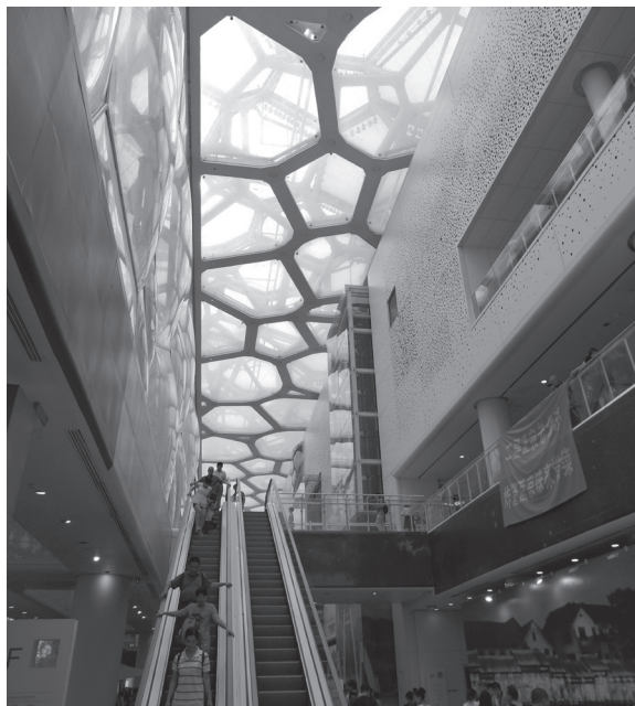
Figura 28. Vista interior del Centro Nacional de Natación de Pekín. Fotografía: Ignacio Valls, 2014.
