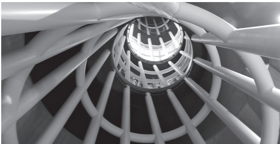
Figura 82. Vista de un pilar de la Mediateca de Sendai, de Toyo Ito. Fotografía: Ignacio Valls, 2014.
