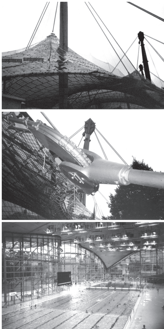
Figura 46. Cubiertas para los edificios de las Olimpíadas de 1972 en Múnich. Fotografías del autor.
