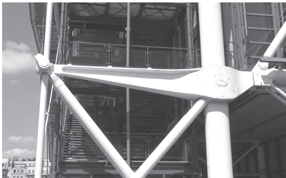
Figura 22. Vigas Gerber del Centro Pompidou, sobre la fachada lateral. Fotografía: Arq. Marcos Dagnino Eirin, 2011.
