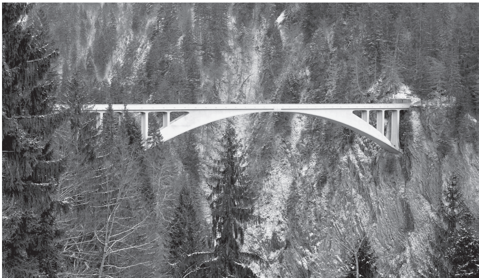
Figura 57. Puente de Salginatobel de Maillart (1930). Fotografía extraída de Internet ( https://commons.wikimedia.org/wiki/File:Salginatobelbruecke_02_11.jpg ), © Chriusha (Хрюша)/ CC-BY-SA-3.0.
