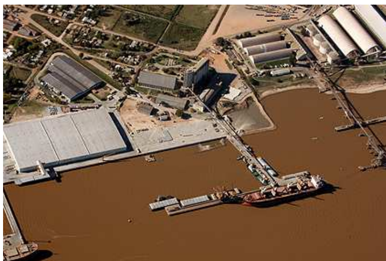
Ilustración 3.3 Puerto de Nueva Palmira. Fuente: A.N.P.
