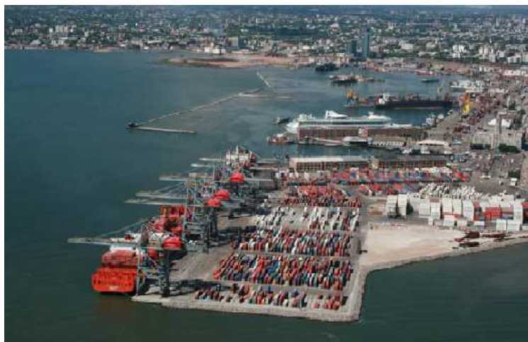
Ilustración 3.2: Puerto de Montevideo vista desde oeste. Fuente: A.N.P.
