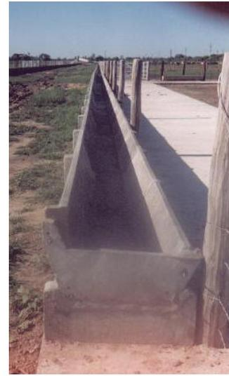
Éstos son instalados sobre piso de hormigón, el cual mide 3 mts de ancho con un espesor de 8 cm, quedando 80 cm de ancho debajo del comedero y 2,20 mts para que pise el animal.
