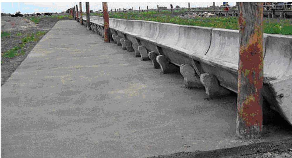
Otro modelo de comederos de hormigón son los de fácil armado, los cuales son muy utilizados en el sistema feedlot. Sus medidas aproximadas son: 1.22 mts. de largo por 0.85 mts. de ancho.
