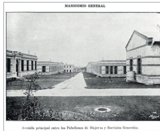
Figura 5. Aquí se observa la vista general que procuró el fotógrafo para mostrar la amplitud y el avance de las obras. Fotografía de Manuel Ramos. Fuente: Porfirio Díaz, Manicomio General. Informe rendido por el ingeniero, contratista, teniente coronel Porfirio Díaz, 1908-1910 , México, Compañía Editora Nacional, 1910, [s. n. p.] (Colección Porfirio Díaz, Biblioteca Francisco Xavier Clavigero de la Universidad Iberoamericana, Ciudad de México)
