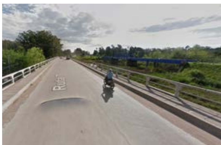
Figura 3.12: Puente vehicular y ferroviario sobre R.N. N° 7 y 26. Fuente: Google Street View
