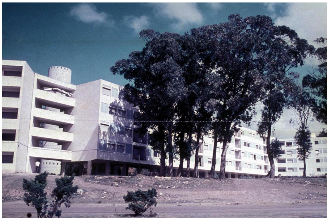
Figura 47. Vista del bloque articulado sobre Bvr. Batlle y Ordóñez, ca. 1966. Archivo Servicio de Medios Audiovisuales, FADU.
