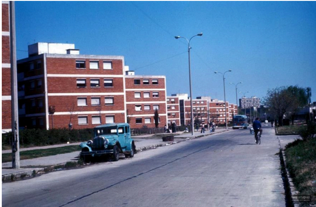
Figura 50. Fotografía de los 32 bloques de vivienda sobre la calle Santiago Rivas, ca. 1966. Archivo Servicio de Medios Audiovisuales, FADU, Udelar.
