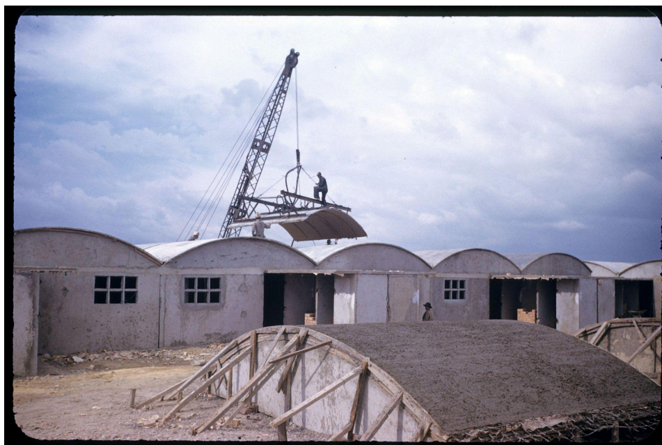
Figura 60. Fotografía de obra en el Barrio Quiroga, 1951. Fuente: CINVA Housing Studies, Currie Collection, Virginia Tech.
