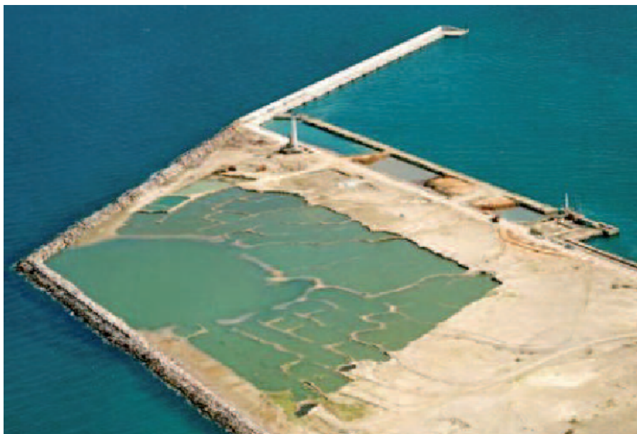
Figura 11.5: Recinto para construcción de la explanada.
