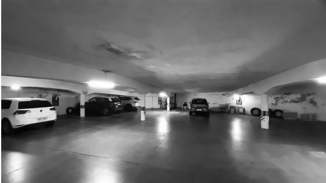
Figura 5. Vista del subsuelo. Fuente: fotografía del autor.
