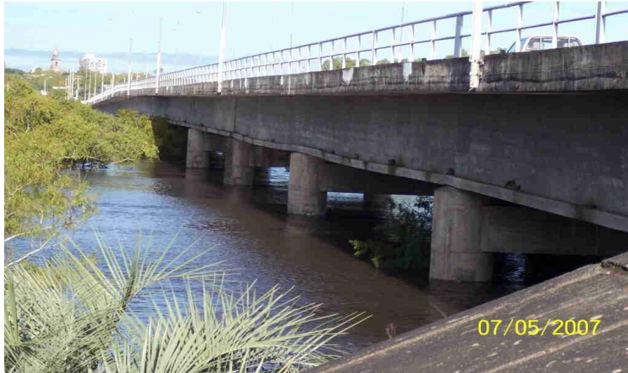
Figura 2.1-1 – Fotografía del puente de la actual Ruta 5 el día 07/05/2007 3
