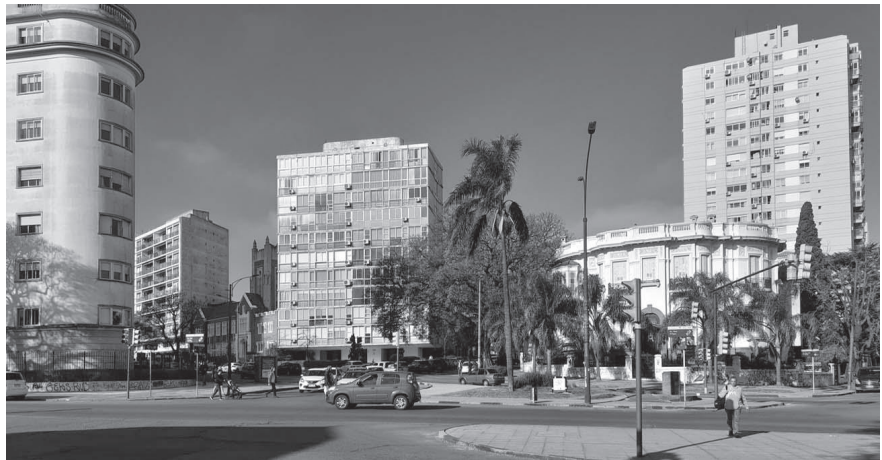
Figura 2: Edificio El Positano y su entorno.
