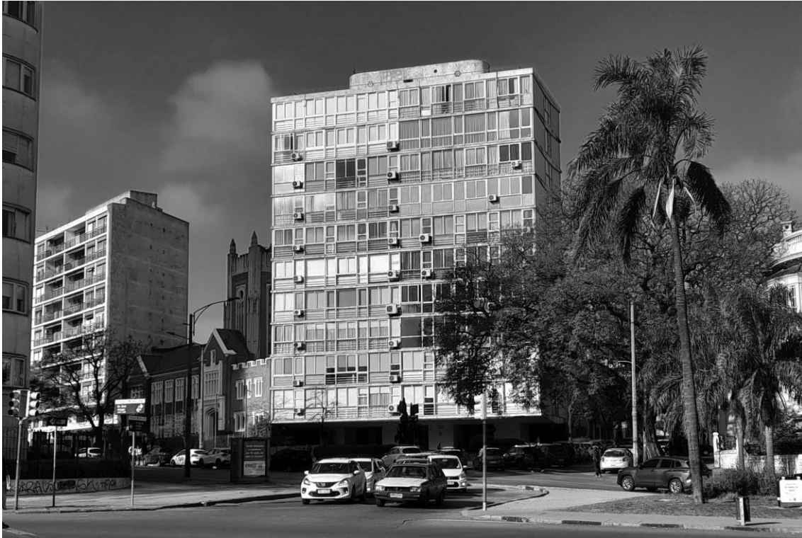
Figura 9. Fotografía del edificio Positano. Fuente: el autor.
