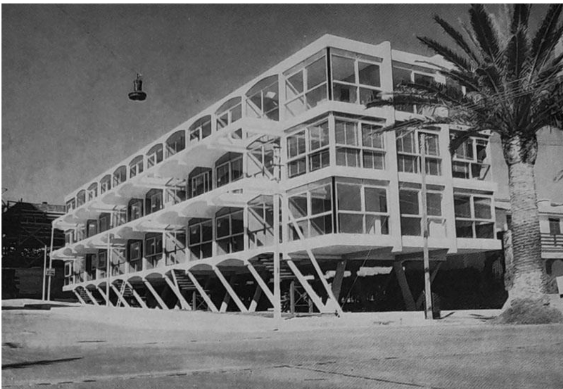
Figura 4. Fotografía del edificio Ruca Malen. Fuente: García Pardo, Luis y Sommer Smith, Adolfo. 1962. "Immeuble d'habitation. Punta del Este, Uruguay". L'Architecture d'Aujourd'hui , núm. 104: XLV.
