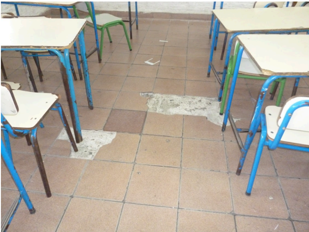
Imagen 6: Estado del mobiliario en centro educativo (aula)
