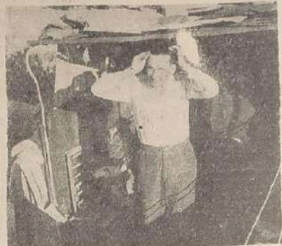
Con cuanto dinero y lata riega puede hallar, este señor construyó su vivienda que podríamos llamar autoconstruida. Su estado que no tiene nada de bueno...
