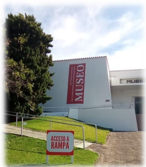
Figura 15: Entrada con rampa al museo
