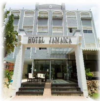
Figura 16: Entrada de Hotel Jamaica
