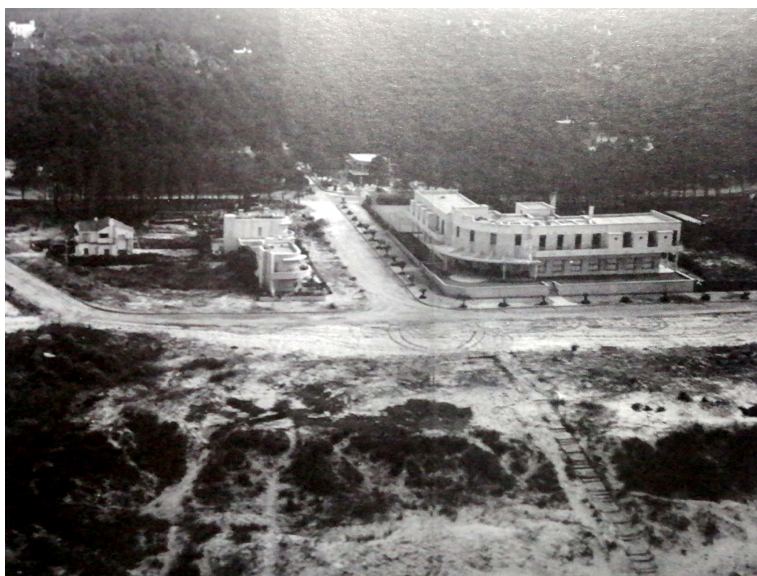
Figura 10. Vista de la rambla sobre la playa “Brava”. Se aprecia en toda su dimensión el Hotel Rex y algunas residencias.
