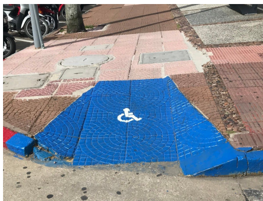
Figura 3: Rampa en la vereda acceso a la calle. Fuente: autora (2020).
