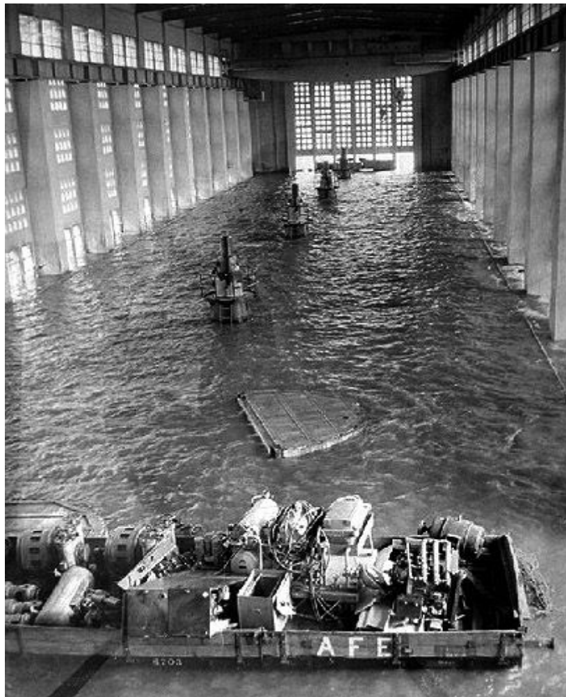
Figura 3. La sala de máquinas anegada de la Represa de Rincón del Bonete [17].
