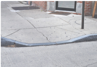
Fig. 9. Una rampa de acceso.
