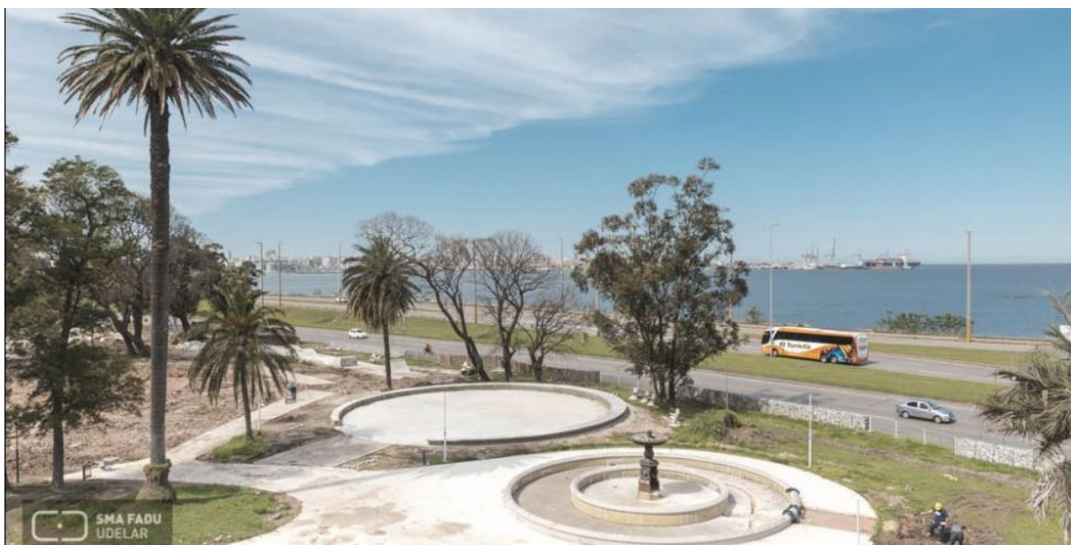
Figura 46: Imagen del Parque Capurro del año 2018, en plena obra previa a la inauguración de 2019. Ahí aparecía la Rambla Baltasar Brum construida entre 1981 y 1983. Fotografía de SMA-Dadu-UdelaR. https://nomada.uy/guide/view/attractions/4570
