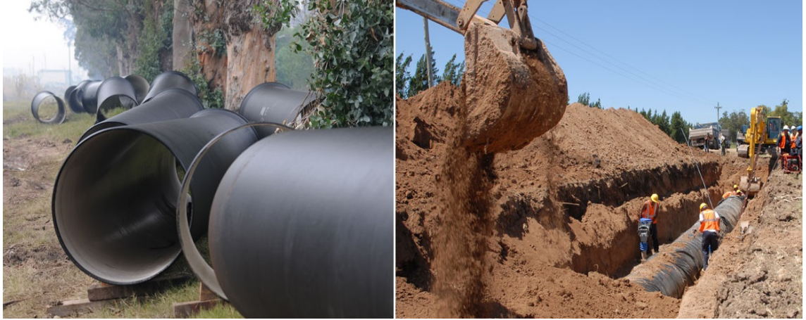
Figura 4.2: Construcción 6 ta línea de bombeo de OSE [OSE].
