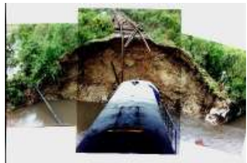
Figura 2. Vista desde el terraplén derecho
