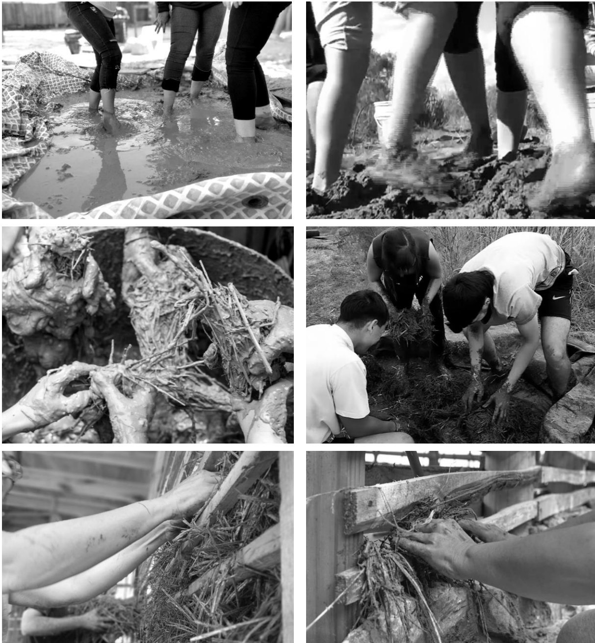
Figura 40: Preparación de la tierra en pisaderos, mezclado de fibras y colocación de rellenos en la trama. Imágenes de mingas y talleres en Las Piedras (2020), Sauce (2010), Parque del Plata (2018), Villa Foresti (2024), Biarritz (2022) y El Pinar (2020). Crédito de imágenes: Tierra Raíz, L. Salas, Biocreare, Pies de Tierra, y Huellas de Barro.
