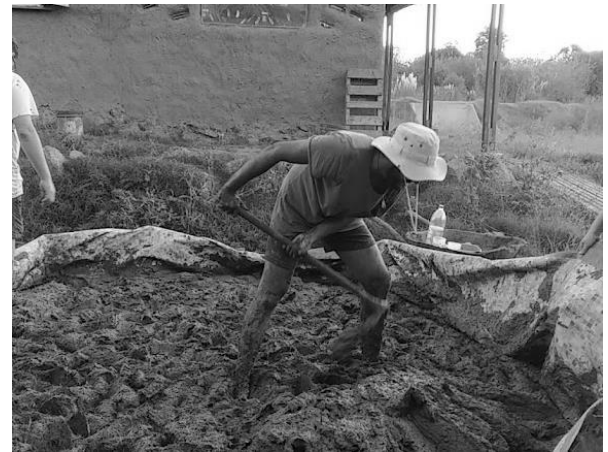
Figura 38: Uso de herramientas de mano para la carga del pisadero en Biarritz (2022) y trabajo en la preparación de la masa de relleno en Las Piedras (2021). Crédito de imágenes: Biocreare y Tierra Raíz.
