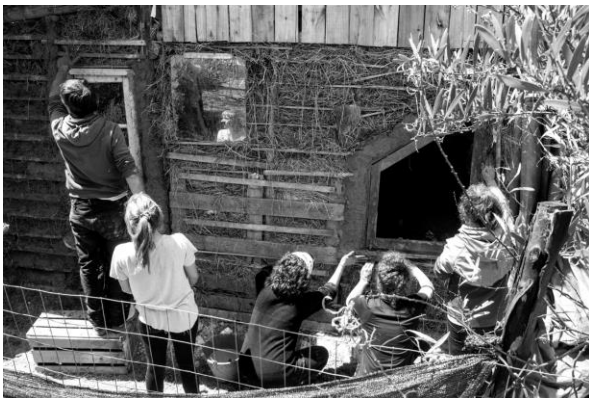
Figura 41: Imágenes de mingas y talleres en obras de personas entrevistadas: (a) trabajo en pisadero en minga en Las Piedras (2021); (b) preparación de tierra alivianada en taller en El Pinar (2020); (c) colocación de trama en muro de fajina en minga en Biarritz (2022); (d) construcción de muros de fajina en minga en Villa Foresti (2024); (e) relleno de muro de fajina en taller en Parque del Plata (2018) y (f) aplicación de revoques en minga en Las Vegas (2017). Crédito de imágenes: Tierra Raíz, Bioconstrucción Uruguay, Biocreare, Pies de Tierra y Curso Educación Permanente FADU.
