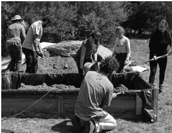
Figura 38: Uso de herramientas de mano para la carga del pisadero en Biarritz (2022) y trabajo en la preparación de la masa de relleno en Las Piedras (2021). Crédito de imágenes: Biocreare y Tierra Raíz.
