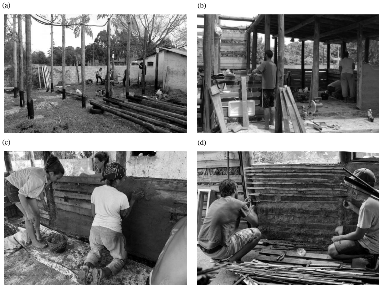
Figura 36: Colocación de palets de madera en muros de fajina en Parque del Plata (2019): (a) posicionado en estructura principal, (b) colocación de palets, (c) relleno y embarrado superficial y (d) colocación de trama complementaria de cañas para soporte de capas de terminación. Crédito de imágenes: Bioconstrucción Uruguay.
