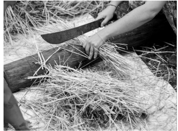
Figura 37: Herramientas para el trabajo con fibras vegetales, tanto como parte de la trama como para su incorporación en los rellenos en obras en Parque del Plata (2018) y El Pinar (2020). Crédito de imágenes: Bioconstrucción Uruguay y Biocreare.
