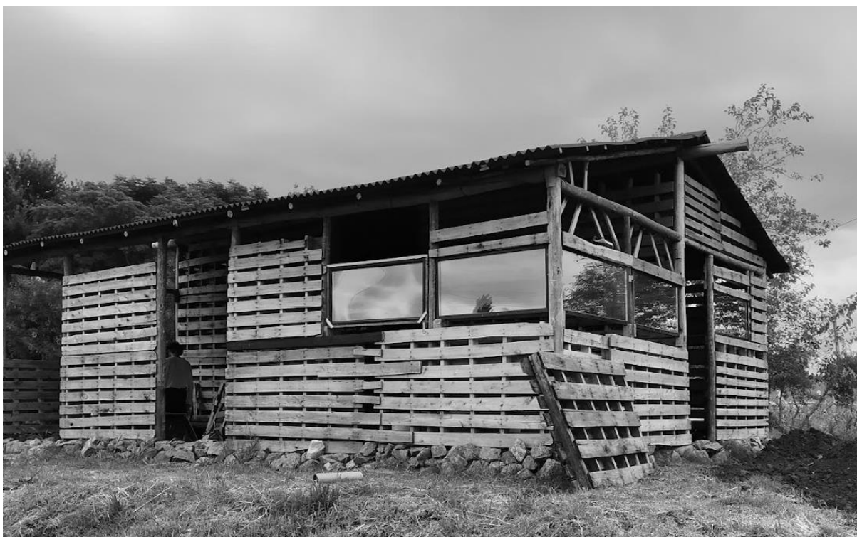
Figura 35: Palets de madera como trama para muros de fajina en Las Piedras (2021). Crédito de imagen: Tierra Raíz.
