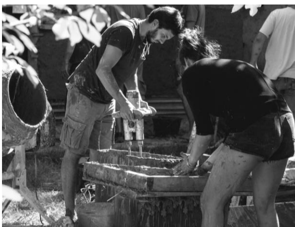
Figura 39: Utilización de equipos mecánicos para la preparación de barbotina y revocos en dos obras en El Pinar (2021 y 2020). Crédito de imágenes: Biocreare y Huellas de Barro.
