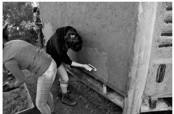
Figura 41: Imágenes de mingas y talleres en obras de personas entrevistadas: (a) trabajo en pisadero en minga en Las Piedras (2021); (b) preparación de tierra alivianada en taller en El Pinar (2020); (c) colocación de trama en muro de fajina en minga en Biarritz (2022); (d) construcción de muros de fajina en minga en Villa Foresti (2024); (e) relleno de muro de fajina en taller en Parque del Plata (2018) y (f) aplicación de revoques en minga en Las Vegas (2017). Crédito de imágenes: Tierra Raíz, Bioconstrucción Uruguay, Biocreare, Pies de Tierra y Curso Educación Permanente FADU.
