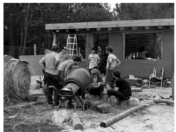
Figura 39: Utilización de equipos mecánicos para la preparación de barbotina y revocos en dos obras en El Pinar (2021 y 2020). Crédito de imágenes: Biocreare y Huellas de Barro.
