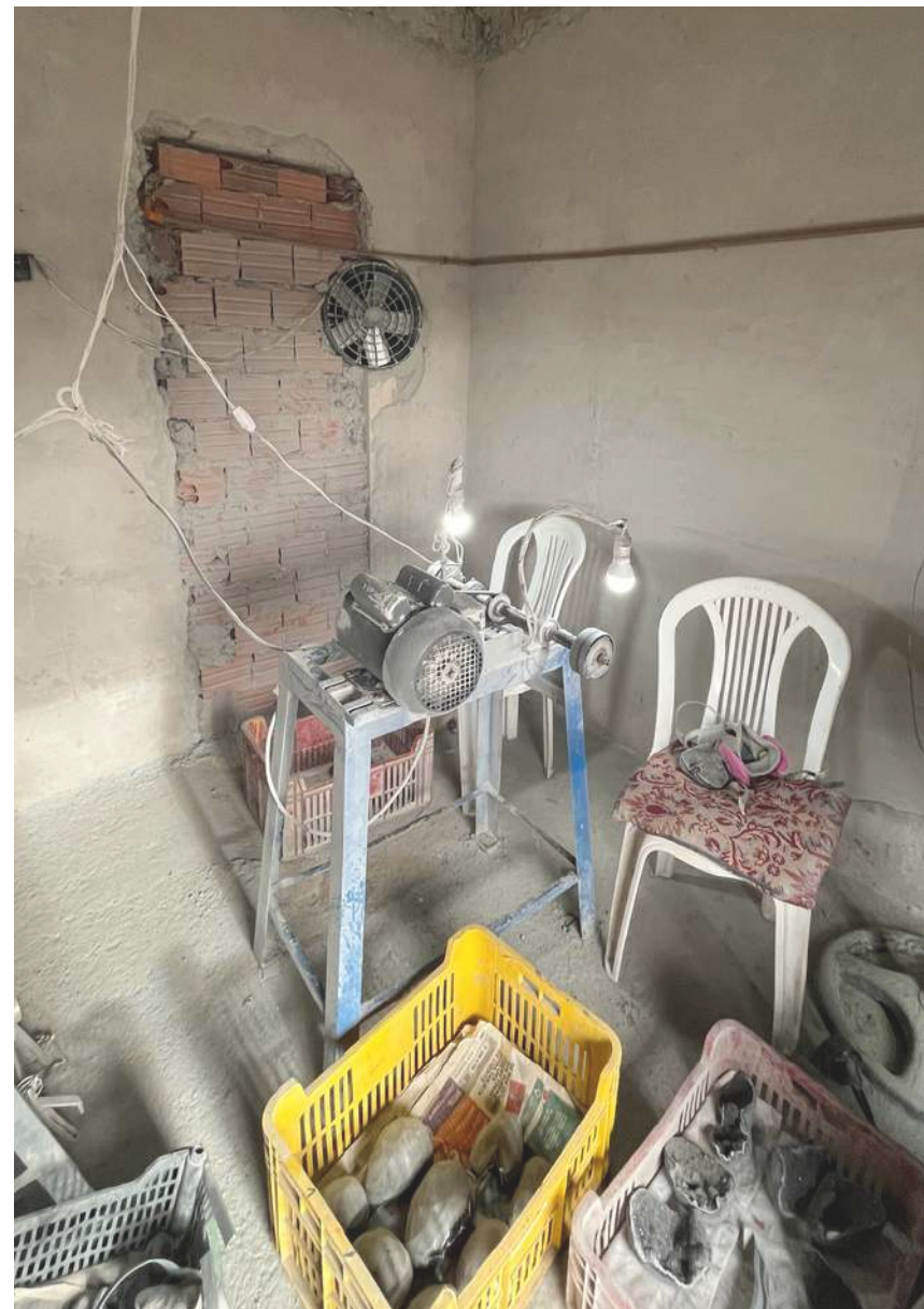
Figura 12. Instalación de extractor para control de polvo. Fuente: elaboración propia.
