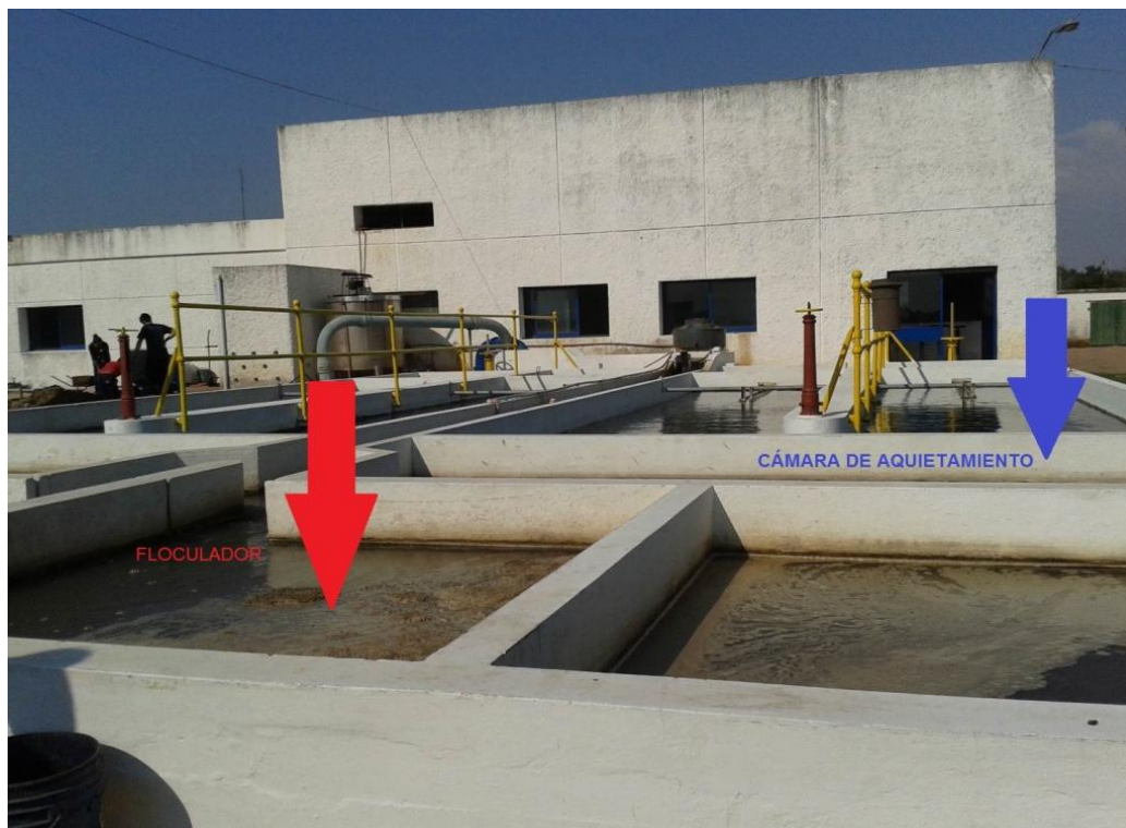
Figura 17: Floculadores tipo COX de flujo helicoidal.
