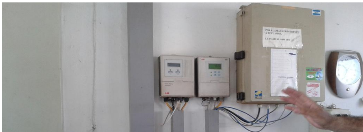
Figura 25: Turbidímetro y caudalímetro.
