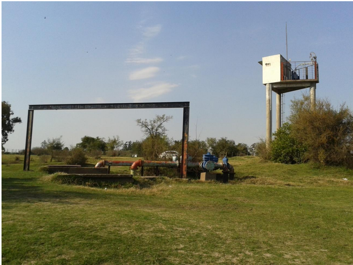
Figura 11: Estructura de toma y aductoras.
