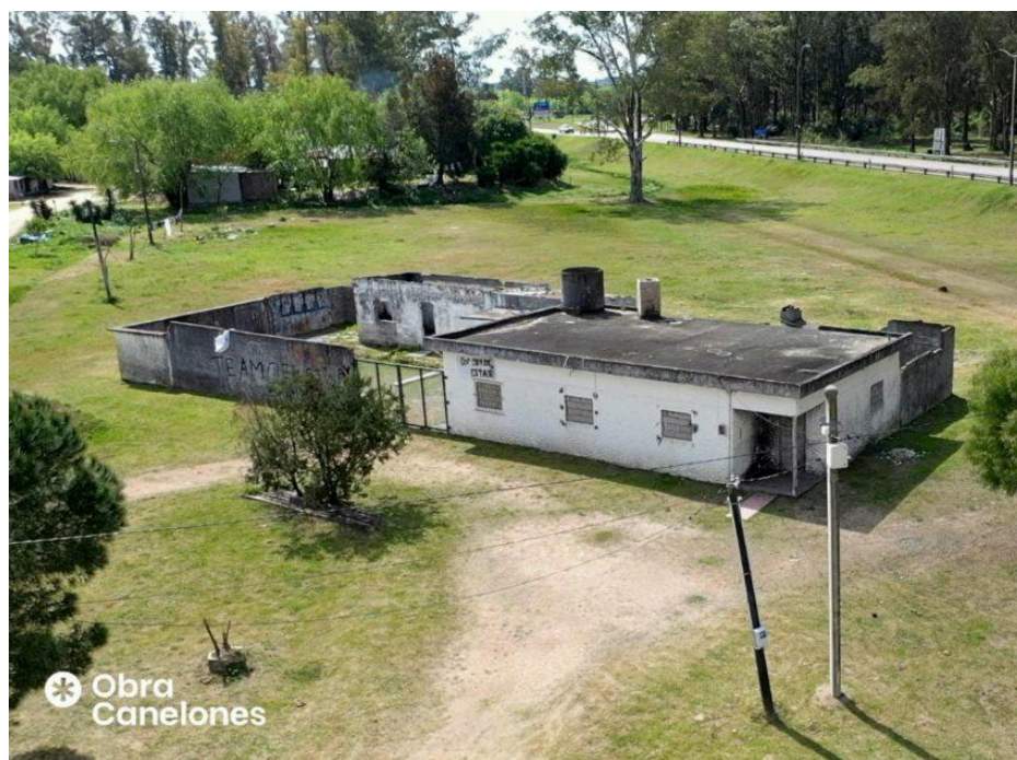
Situación previa a las obras: área del Sitio de Memoria Los Vagones - Barrio Olímpico. Fecha de consulta: 07/06/2025. Fuente: https://www.obracanelones.uy/sitio-de-memoria-los-vagones/
