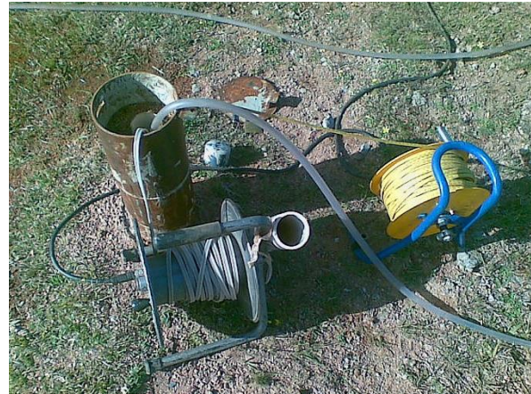
Figura 6: Carretel de manguera, cable de la bomba y piezómetro ubicado en la perforación (fuente: producción propia)
