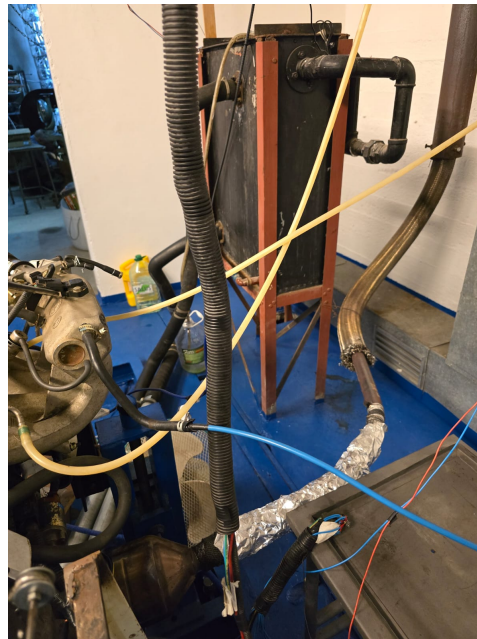
Figura A.14: Sistema de escape de emisiones. Elaboración propia.
