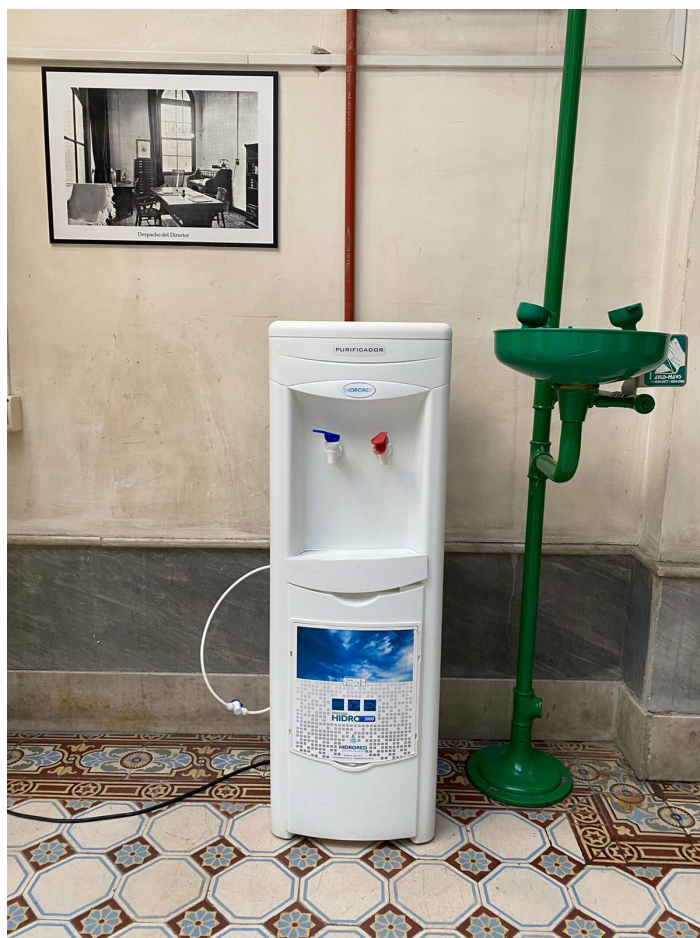
Figura 1. Equipo purificador Hidrored C3000.
