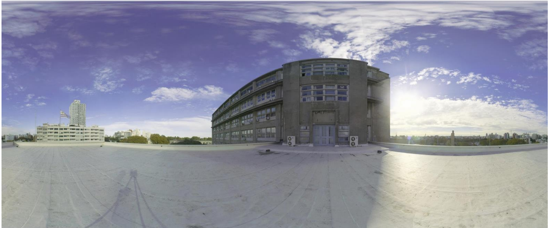
Figura 46: Azotea sobre cuerpo Norte. Fuente: Escáner utilizado.
