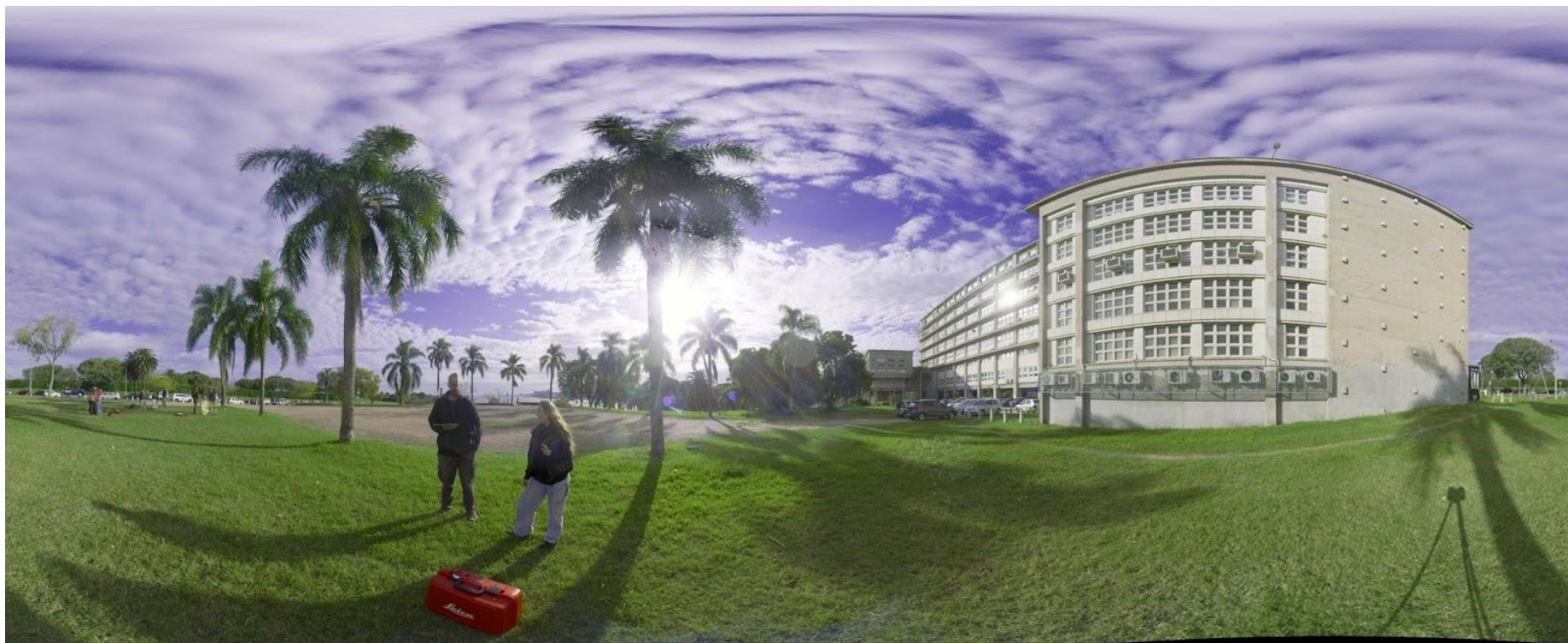
Figura 44: Cuerpo sur fachada oeste. Fuente: Escáner utilizado.
