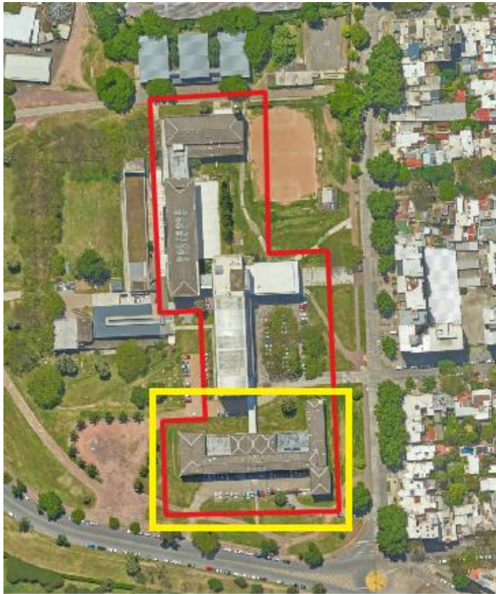
Figura 27: Cuerpo sur del edificio seleccionado en amarillo. Fuente: Elaboración propia.
