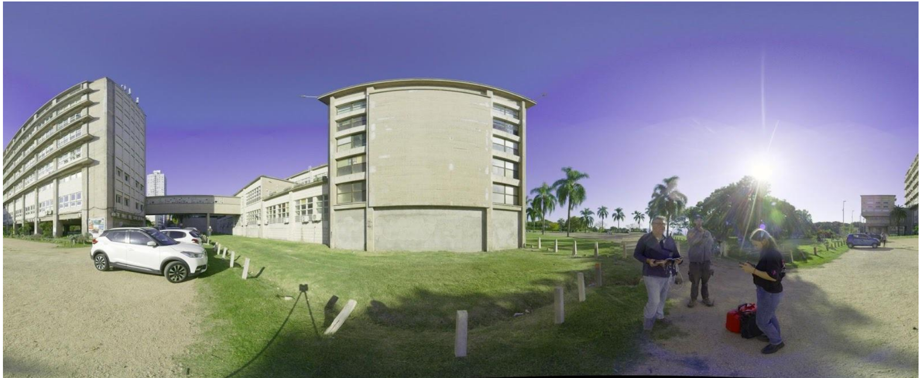
Figura 43: Fachada norte, cuerpo sur. Fuente: Escáner utilizado.
