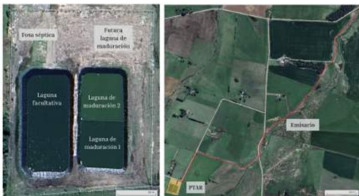
Figura 5: PTAR de los planes III y IV. En la figura se muestran las unidades construidas del sistema: en el panel izquierdo se observa la fosa séptica y el conjunto de lagunas facultativa y de maduración, mientras que en el panel derecho se presenta la ubicación en planta del emisario del efluente tratado.
