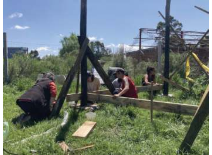
Colocamos los pilares y vigas de la estructura de madera.
