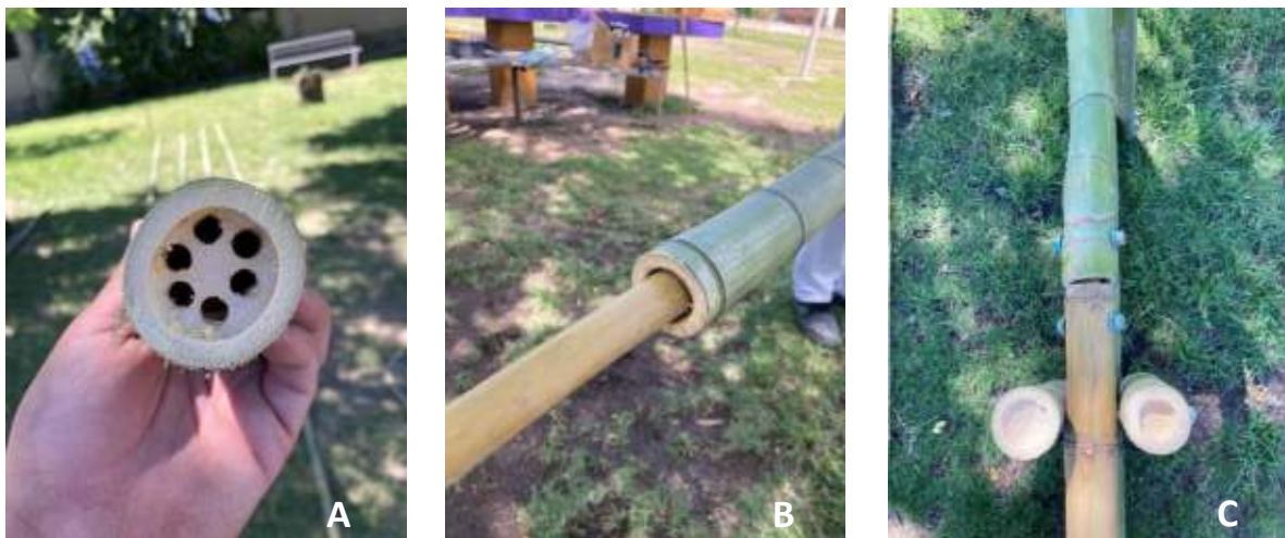
Figura 23 – Dispositivo de unión 6. a) Detalle de perforación de culmo, b) Detalle de colocación de culmo pasante de menor diámetro, c) Detalle de posicionamiento y fijación de culmos a tope.
