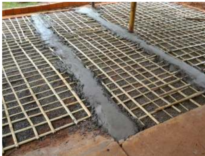
Figura 4: Uso del bambú para armadura de repartición de cargas en hormigón (istockphoto, 2016)
