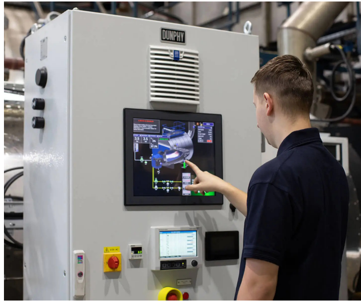
Figura 5.1: Ejemplo de tablero industrial con control mediante HMI
