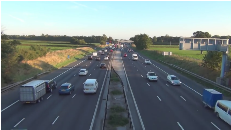
Figura 3.1: Vista frontal elevada de la M6 Motorway en Reino Unido.
